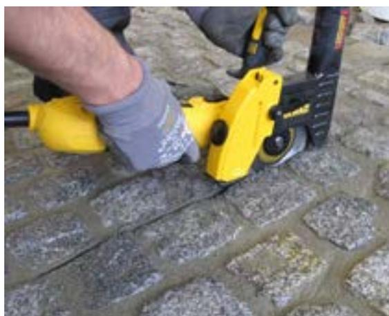
Вырезанный впоследствии деформационный шов / место разрыва заполняется уплотнительным материалом. Таким образом, опорная часть сохраняется.
