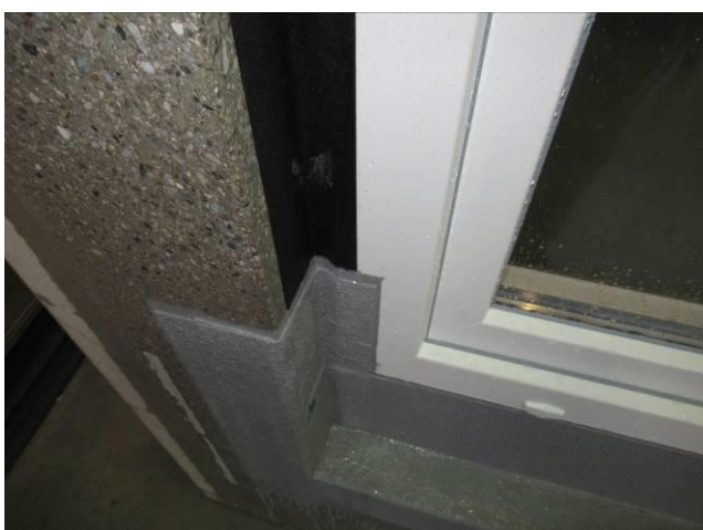
Рис. 5 Изоляция в нижней части, левая сторона, лента приклеена к коробке, жидкий пластик
