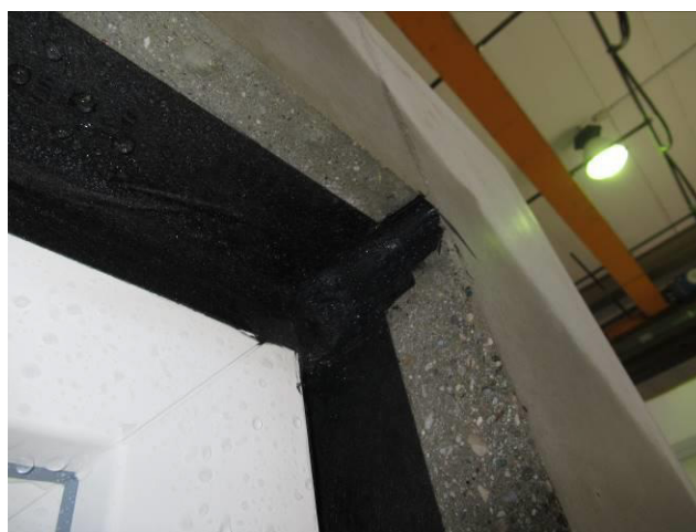
Рис. 4 Монтажная лента по сторонам и сверху, правая сторона, лента приклеена к коробке
