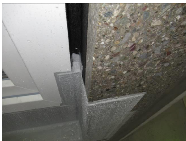
Рис. 6 Изоляция в нижней части, правая сторона, лента приклеена к коробке, жидкий пластик
