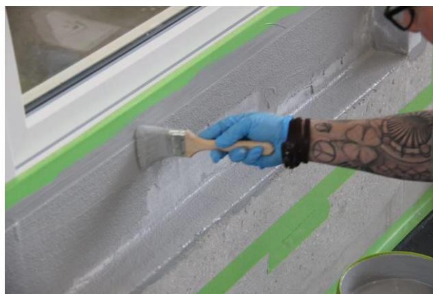
Рис. 12 Подготовка образца для испытаний, правая сторона снизу, нанесение второго слоя жидкого пластика на флис
