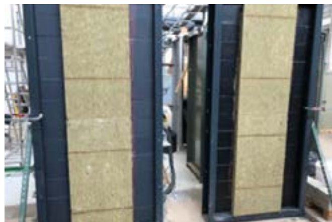
Обе стены готовы к испытаниям
