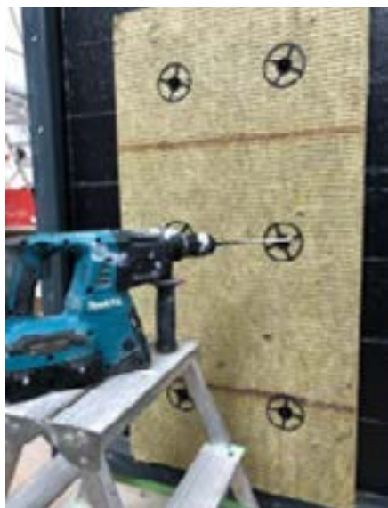
сверильный станок со сверлом на 8 мм
