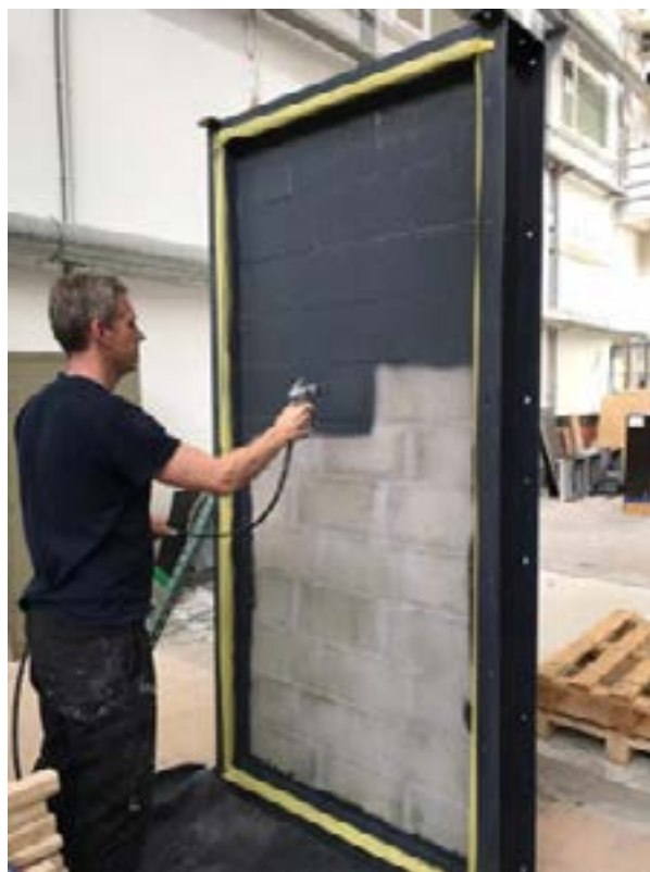
Безвоздушное нанесение «ИЗОПРУФ ФР»
