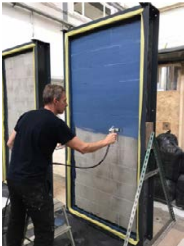
Безвоздушное нанесение «БЛОВЕРПРУФ® ЛИКВИД»
